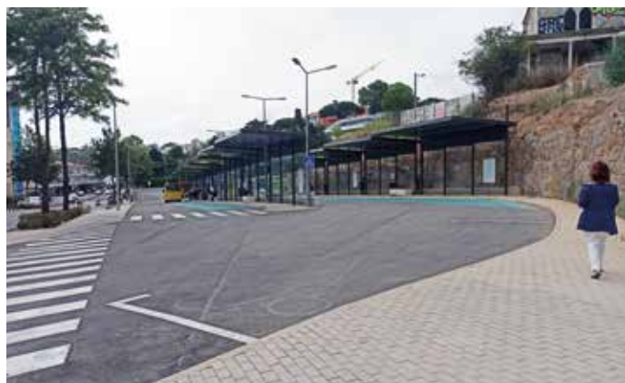
Novo terminal de camionagem (Cascais)
