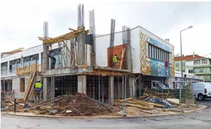
Obras no mercado de Queluz (Sintra)
